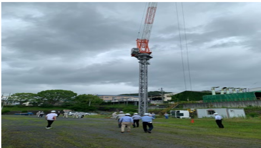
写真 遠隔操作クレーン調査
