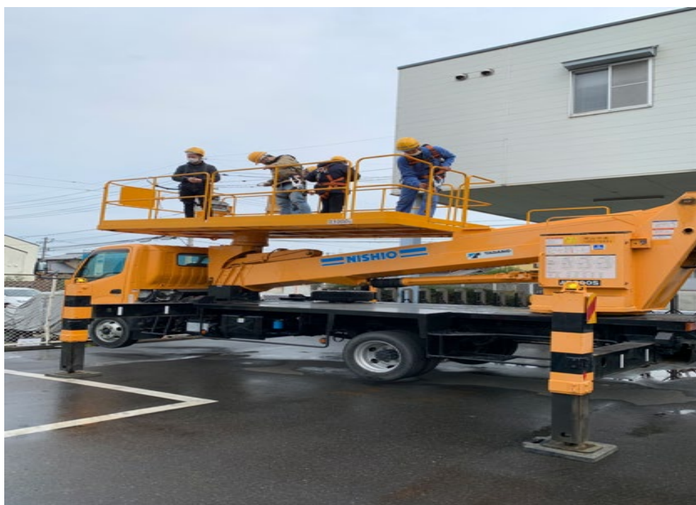
写真 遠隔操作型高所作業車体験状況
