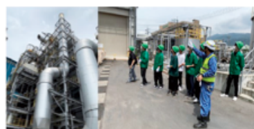
全員同じように見上げる3万戸分の電力を生むバイオマス発電所
