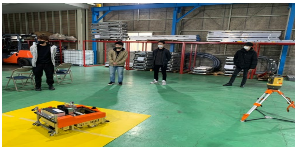
写真 墨出しロボットの稼働状況視察
