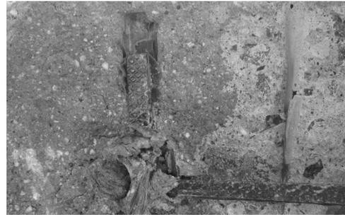
写真-6 CFG 板上端の下方へのずれ
